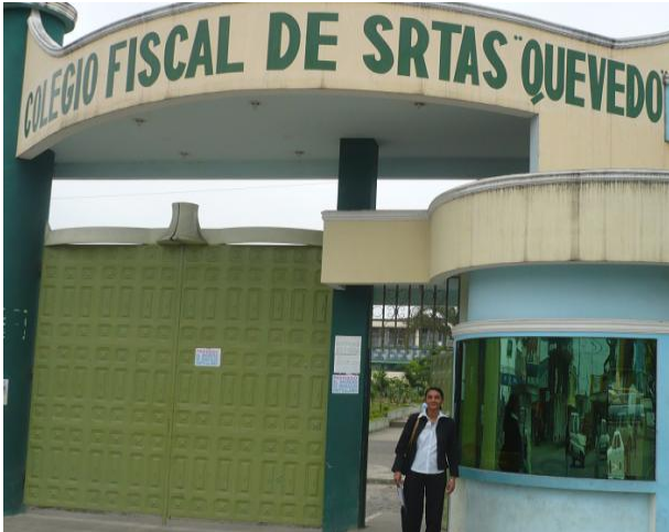
1.- Ingreso principal del Colegio "Srtas. Quevedo"
